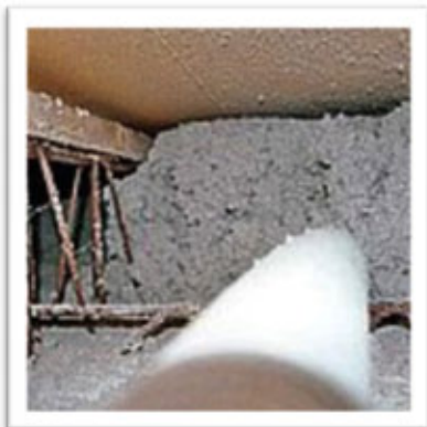
Dach mit Zellulosen Dämmstoff füllen www.dach.de
