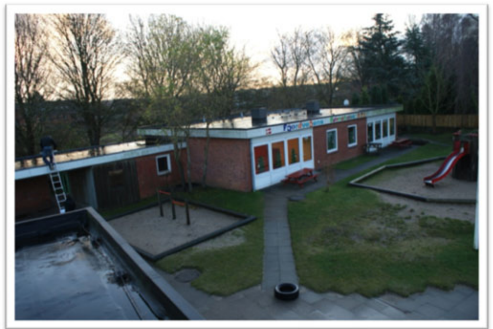
Dach, Pergola und Haus 2
