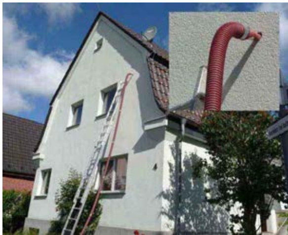
Bild 26 Verbesserung durch einfüllen der Kerndämmung
