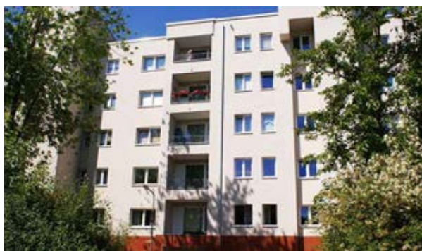
Bild 25 Mehrfamilienhaus der Heinrich-Lübcke-Siedlung nach der Sanierung
