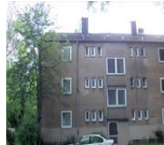
Bild 57 Fordsiedlung vor der Sanierung
