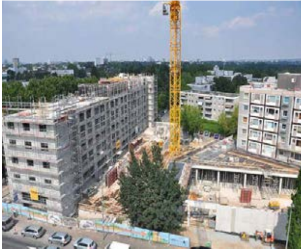
Bild 24 Bauphase der Heinrich-Lübcke-Siedlung
