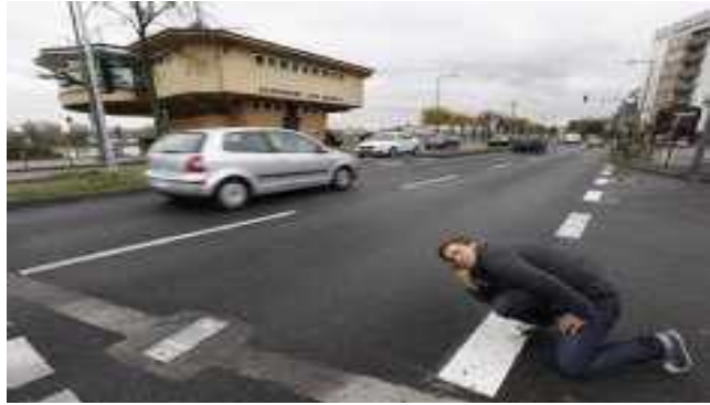
Bild 12 Flüsterasphalt bei der Erprobung in Köln
