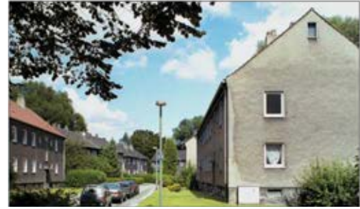
Bild 60 GE-Lindenholz vor der Sanierung
