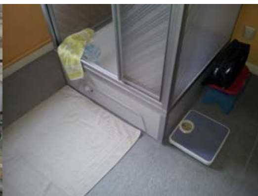
Bild 30 Dusche mit eingebautem Durchlauferhitzer
