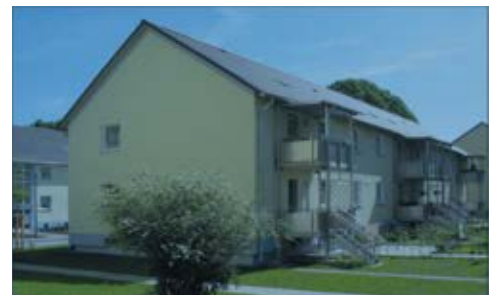
Bild 61 GE-Lindenholz nach der Sanierung
