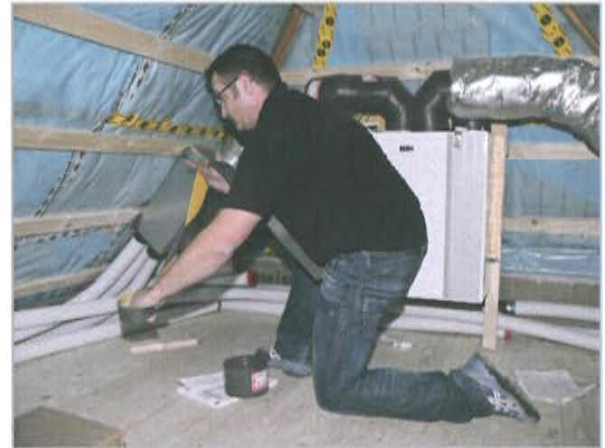
Ist die Lüftungsanlage korrekt installiert? Manuel Hinrichs-Böttcher überprüft die Ausführung der Arbeit.
