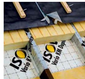
Abbildung 4: Zwischensparrendämmung
