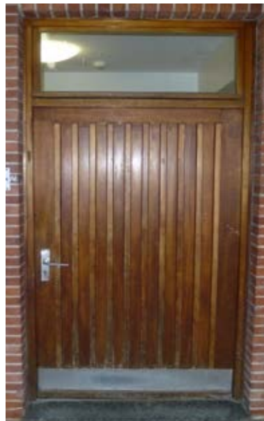
Holztür mit Oberlicht
