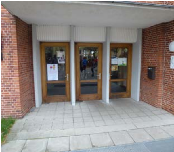
Holztür mit einer Einfachverglasung
