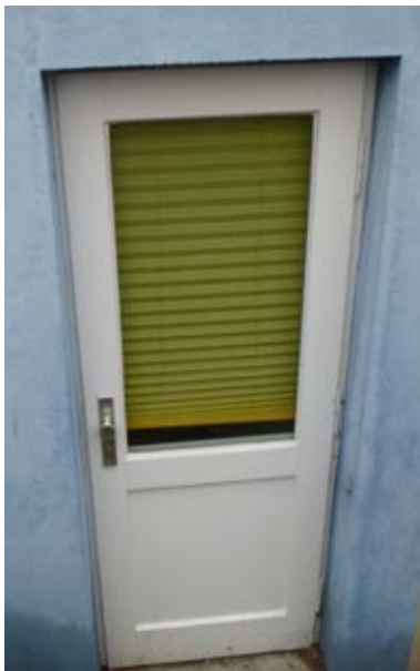
Holztür mit Einfachverglasung Kellerzugang
