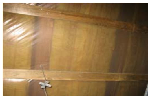
Innenansicht Dach vom Gartenhaus
