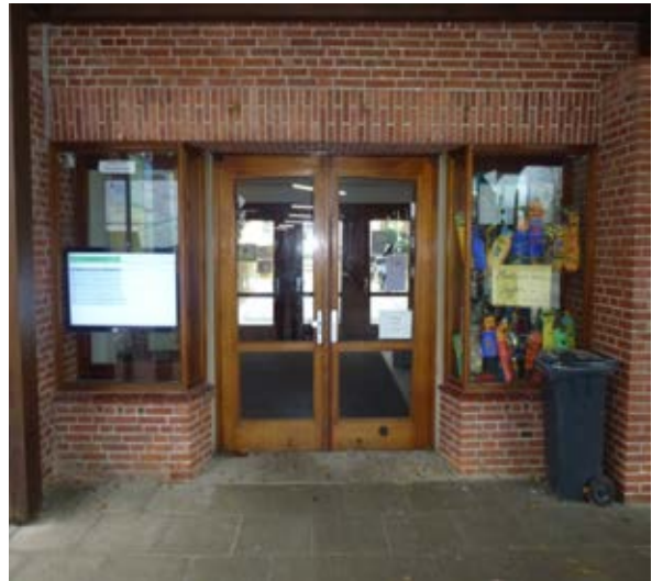
Holz-Doppelflügeltüren mit einer Einfachverglasung
