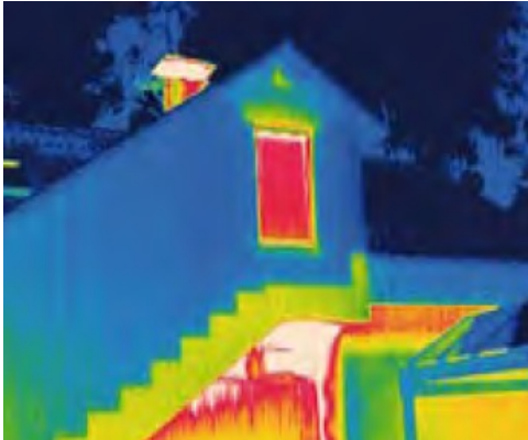
Visualisierung von Wärmebrücken durch Betonträger Quelle:www.dena.de
