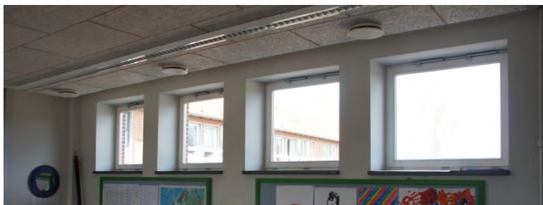
Abbildung 5 Nordwand der Klassenräume 7
