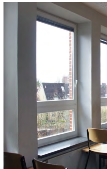
Abbildung 6 Südwand der Klassenräume 8
