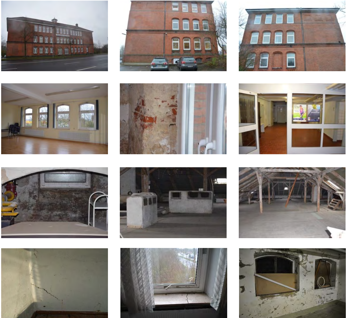
Abbildung 1: Eindrücke vom baulichen Bestand
