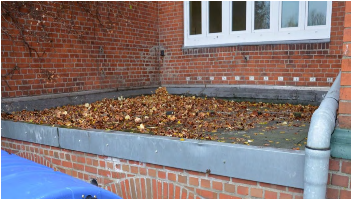
Abbildung 12: Dach WC Kellergeschoss
