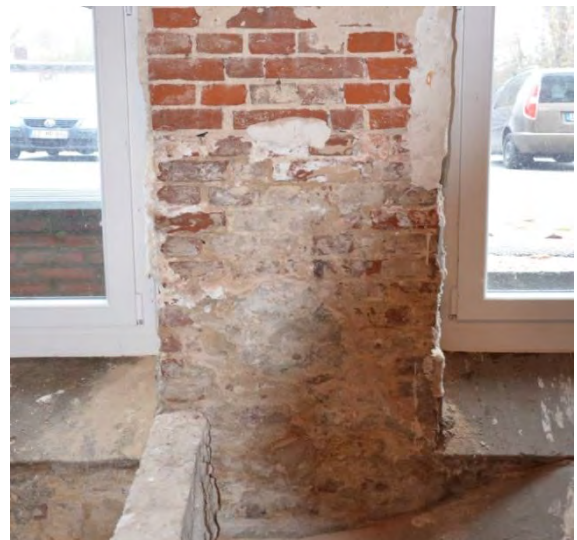
Abbildung 6: Außenfassade und Feuchteschäden am Kellergeschoss
