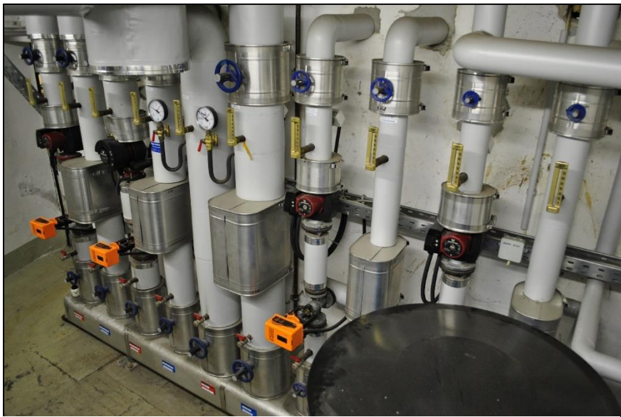
Abbildung 4 | Heizkreisverteiler
