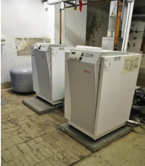
Abbildung 3 | Brennwertkessel Elco Rendamax
