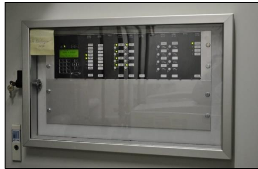
Abbildung 11 | Bedienelement Heizungsregelung
