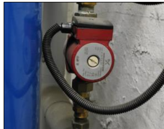
Abbildung 8 | Zirkulationspumpe
