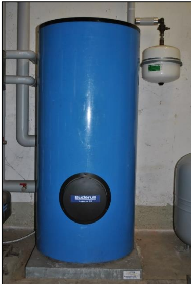
Abbildung 9 | Trinkwasserspeicher
