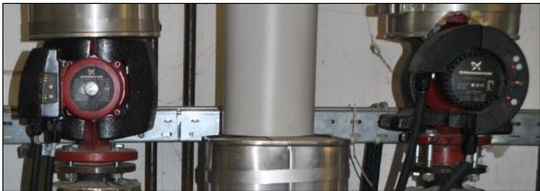
Abbildung 6 | Heizkreispumpen
