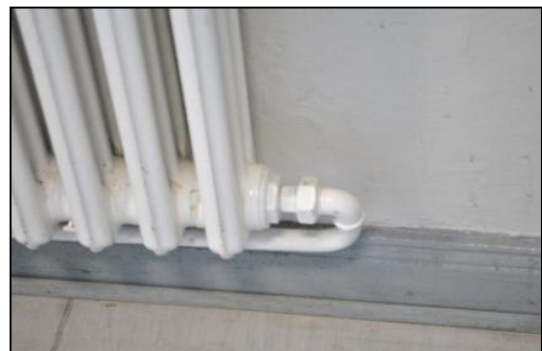
Abbildung 14 | Rücklaufverschraubung
