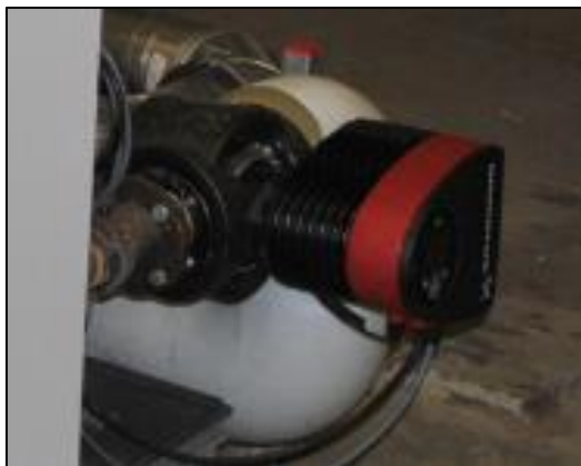
Abbildung 7 | Kesselkreispumpe
