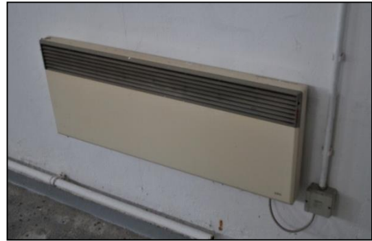
Abbildung 13 | elektrische Direktheizung
