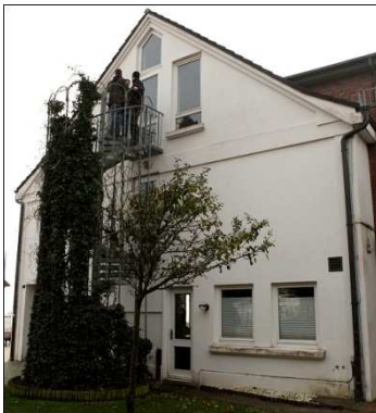
Abb.5 Fassade Altbau, Nordseite, Fenster
