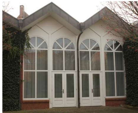
Abb.10 Fassade Veranstaltungssaal, Türelement
