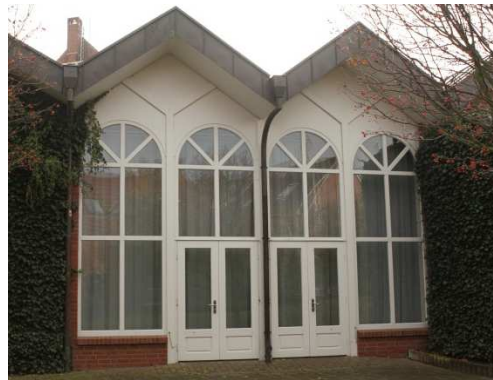
Abb.6 Fassade Veranstaltungssaal, Türelement
