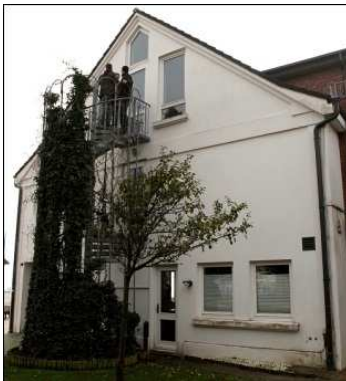
Abb.9 Fassade Altbau, Ostseite, Fenster
