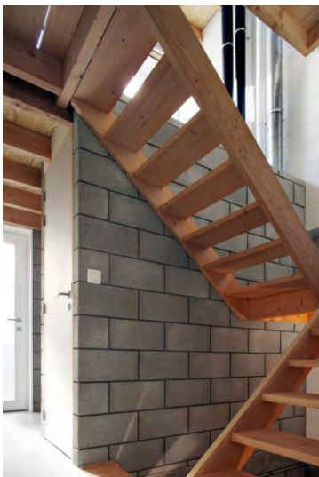
EG Treppenhaus Blick zur Haustür
